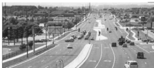
Figura 2.37 Ejemplo de un excelente control de accesos en un camino arterial.
